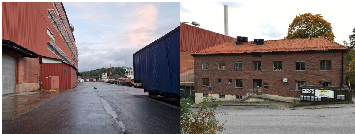
Figur 11. Till vänster kontorsbyggnaden sedd från Kvarnholmsvägen. (Nacka kommun, 2019). Till höger vy längs med kajen mot öster vid d Kafferosteriet. (Nacka kommun, 2023)
